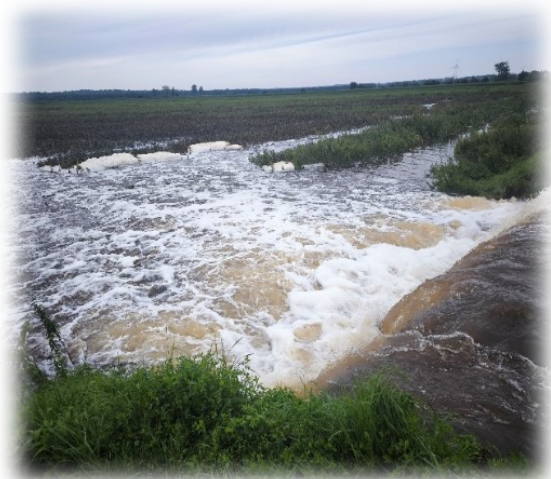
Rysunek 4. Przerwanie wału w miejscowości Święty Gaj w powiecie elbląskim.
