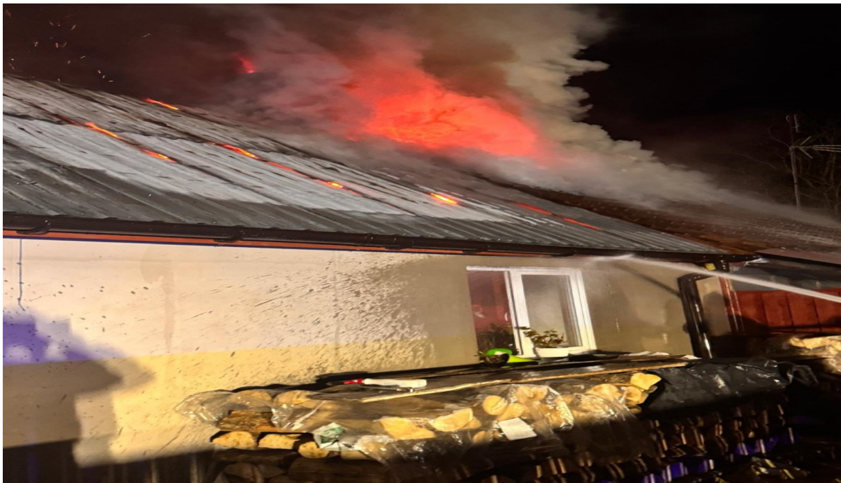
Rysunek 2. Pożar budynku mieszkalnego w miejscowości Stegny, gm. Pasłęk.
